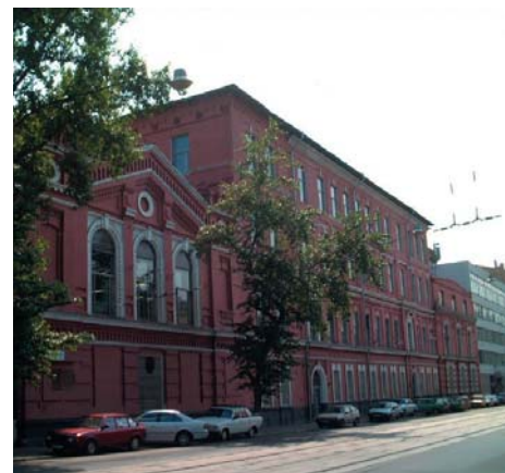
Здание ОАО МТЗ ТРАНСМАШ.
